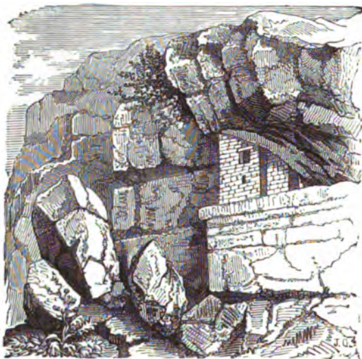
Fig. 148. — Construction découverte à Rattlesnake Bend, à 30 mètres au-dessus du niveau de la rivière.
